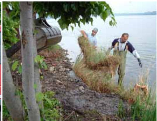
A sinistra: ancoraggio del rullo con pali in castagno, aprile 2007. A destra: particolare del rullo posato e ancorato, aprile 2007.
