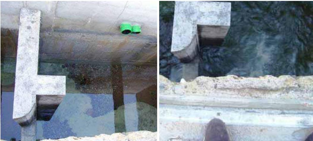
Esempio di setto di tipologia "mista" realizzato per il passaggio per pesci sullo sbarramento tra il Lago di Lugano ed il Fiume Tresa in comune di Lavena Ponte Tresa (VA). Sbarramento di regolazione del lago. Nell'immagine ad acqua ferma è apprezzabile la sedimentazione sul fondo che indica le zone a minore e maggiore velocità dell'acqua.
