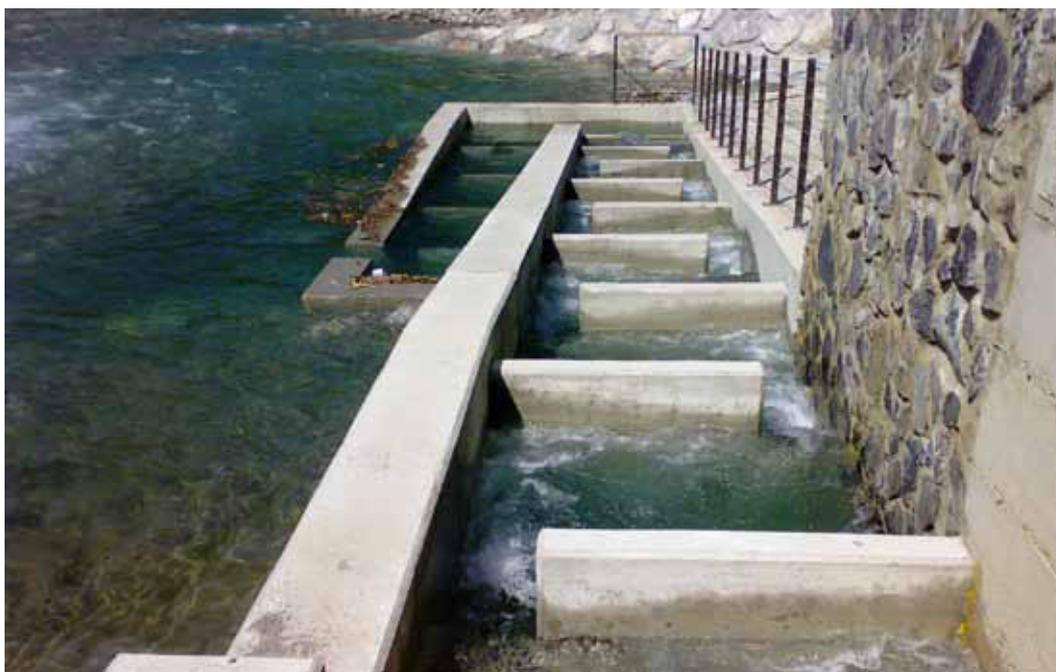
*Esempio di progettazione cautelativa di un imbocco di valle. I livelli idrici reali sommergono gli ultimi bacini ma permettono un ottimo funzionamento dell'opera. Fiume Brembo in Comune di Villa d'Almè (BG).*
