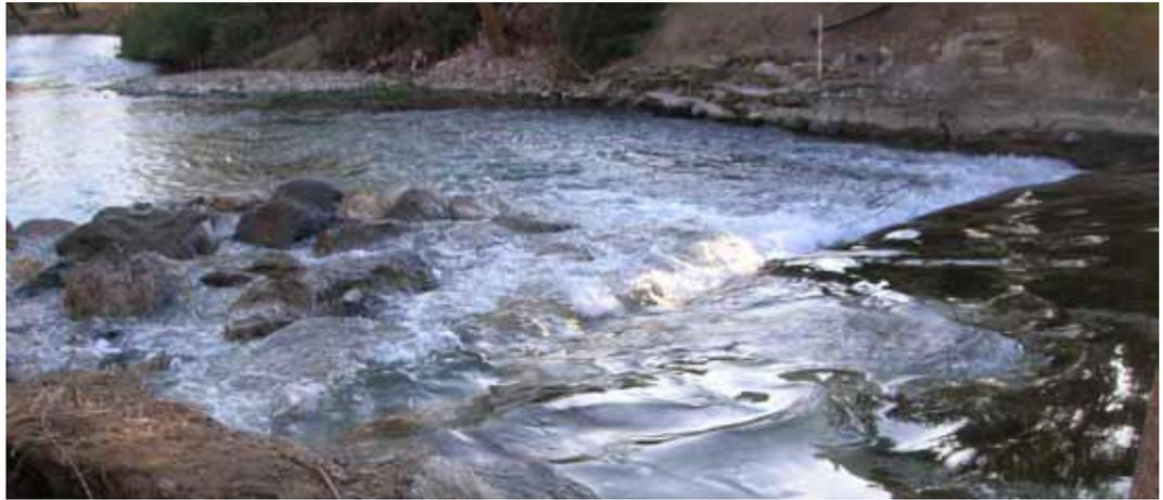
Le caratteristiche idrauliche della rampa dipendono dalla sua geometria, dalla portata e dalla scabrezza del materiale utilizzato per costruirla. Come per i passaggi tecnici, anche la progettazione delle rampe in pietrame deve seguire ad uno studio approfondito dell'idrologia del corso d'acqua nel tratto di interesse e delle condizioni idrauliche che si verificano a monte. La sua progettazione richiede preventivamente la determinazione di una serie di variabili, comprendenti:
