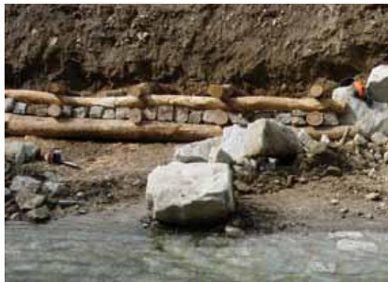
A sinistra: riempimento della palificata con pietrame. A destra: vista frontale di una palificata in costruzione.
